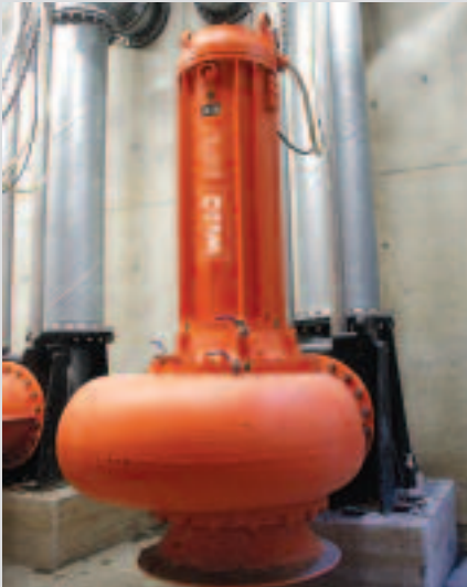
Behälteraufstellung Wet sump installation Montage immergé
