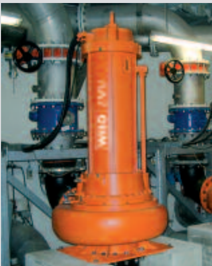
Trockenaufstellung Dry sump installation Montage à sec
