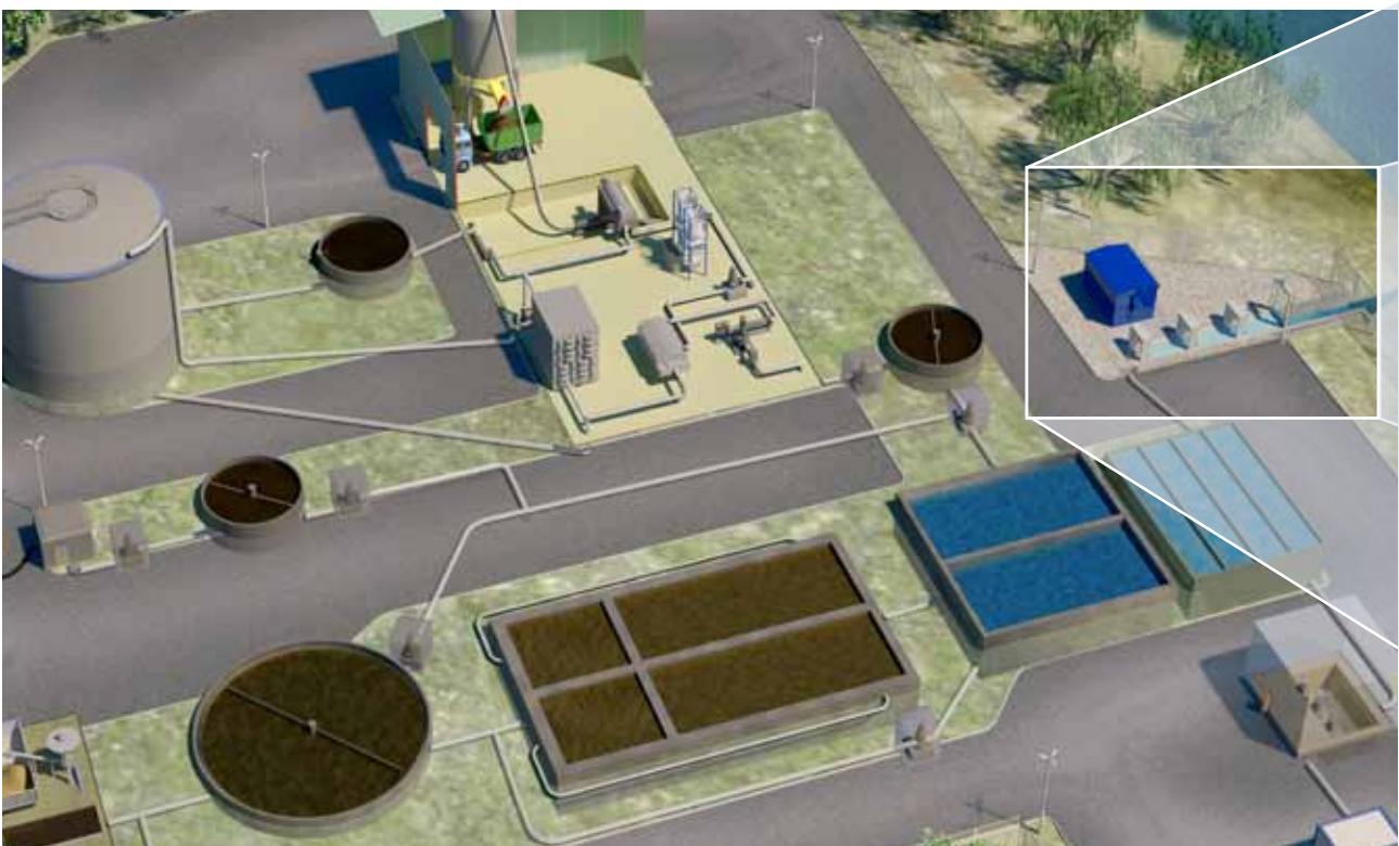
Vue d'ensemble d'une station d'épuration avec désinfection UV TAK 55 WEDECO comme étape finale de traitement
