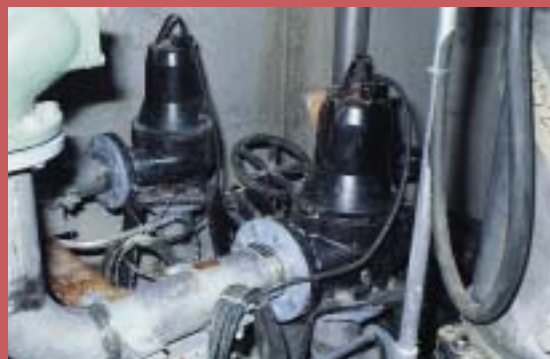
Pompes installées verticalement avec stator favorisant échange thermique avec air ambiant.
