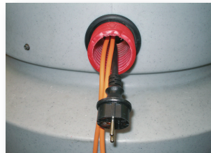
Passage de câbles
