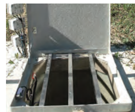
Tampon polyester sur coffrage perdu
