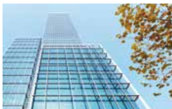
Immeuble de grande hauteur sans podium
